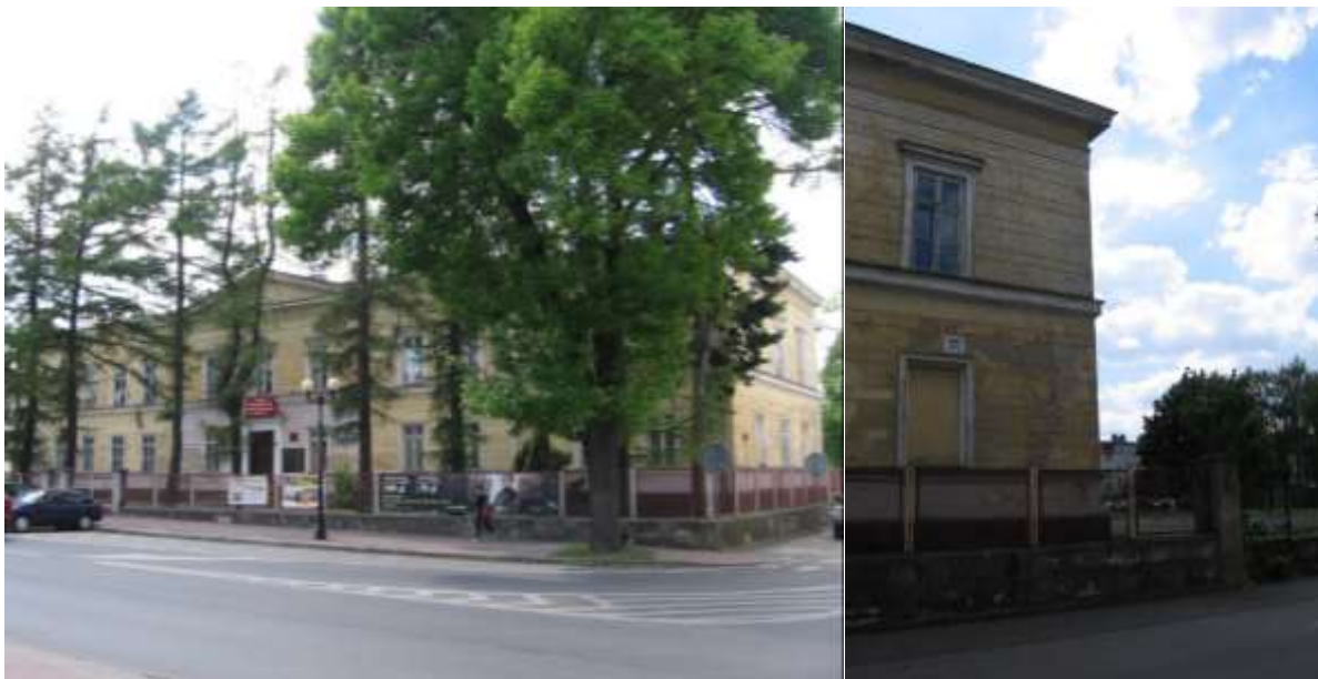
Fotografie: Widok na niszczący budynek byłego Liceum Ogólnokształcącego – widok od wejścia przy ul. Stanisława Konarskiego oraz widok ściany bocznej i ogrodzenia od ul. Mieczysława Aśtanowicza
