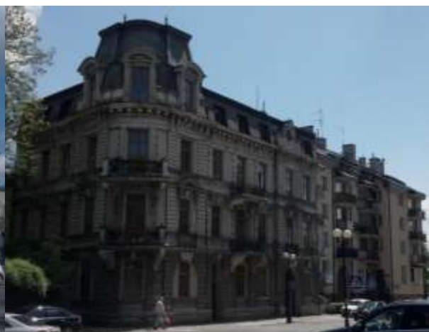
Fotografia: Kamienica przy ul. Floriańskiej
