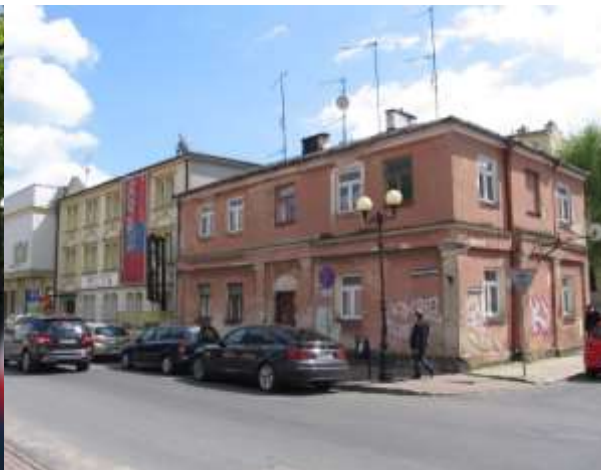
Fotografia: Budynki przy ul. Biskupa Ignacego Świrskiego
