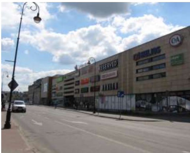
Fotografia: Galeria Siedlce przy ul. J. Piłsudskiego – widok od ul. Wojskowej
