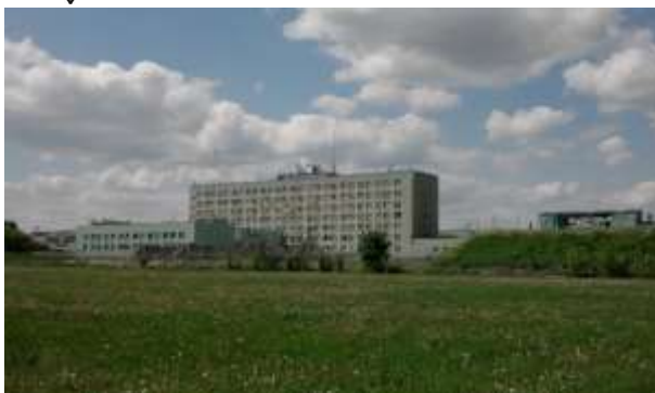
Fotografie: Mazowiecki Szpital Wojewódzki widok od strony ul. Starowiejskiej oraz widok od strony parkingu przy ul. Wiszniewskiego
