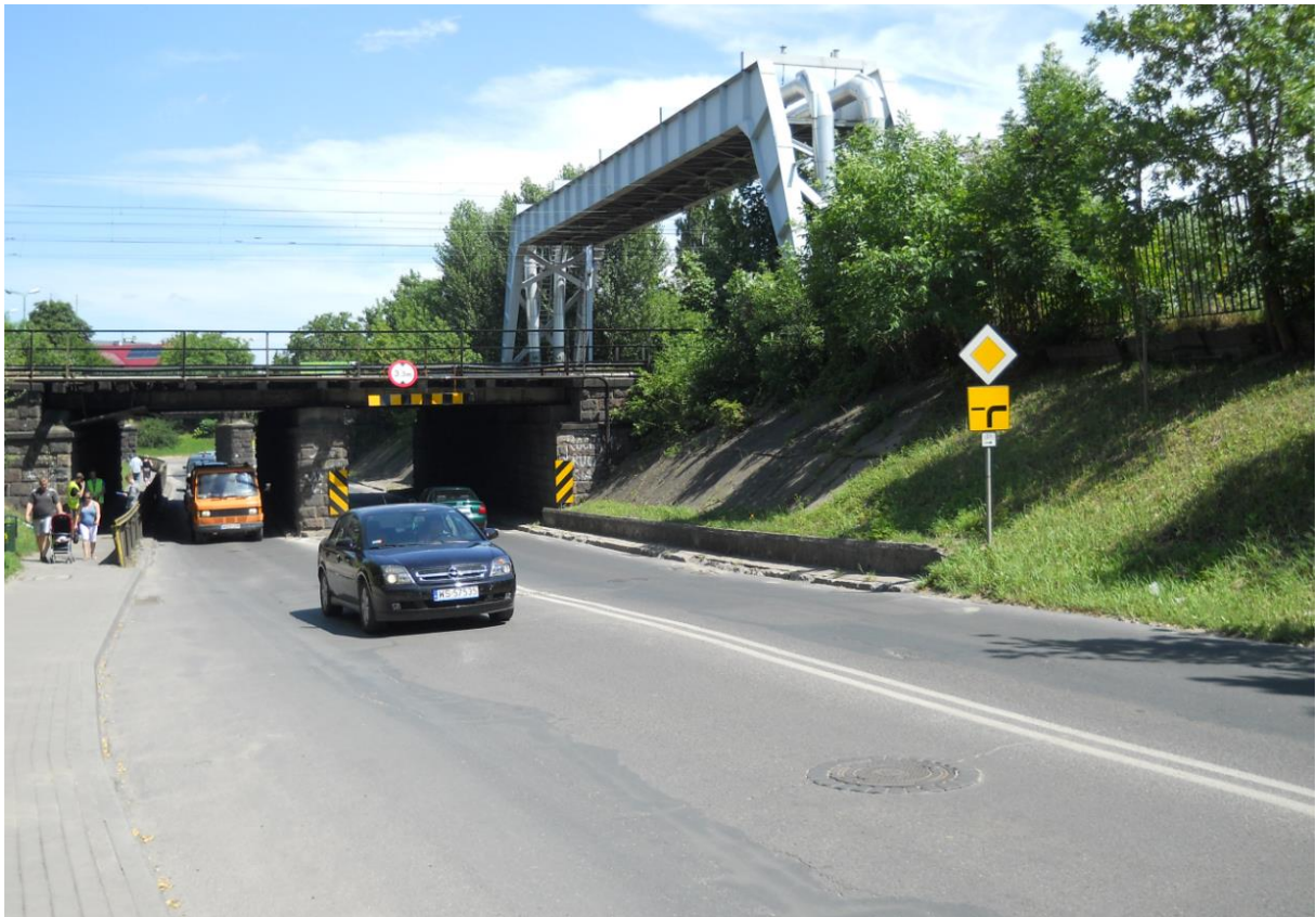
Fot. 1. Widok z ul. Partyzantów w kierunku ul. 3 Maja. Na fotografii pokazano miejsce pod budowę wiaduktu drogowego. W tle widać istniejący wiadukt kolejowy.
